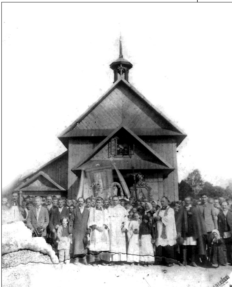
Dzwola, lata 20. XX w. Kaplica używana podczas budowy kościoła murowanego
