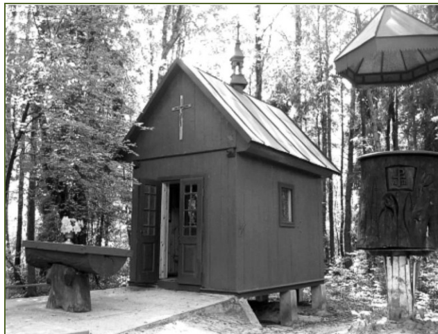
Kaplica św. Antoniego w Kruczku. Z prawej widoczna ambona
