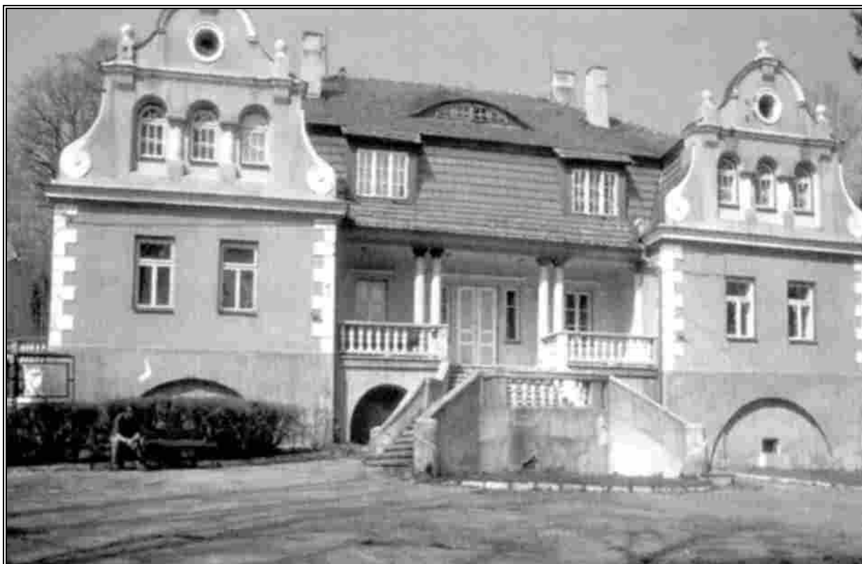
Jeden z najpiękniejszych zabytków Ziemi Janowskiej – dwór Gustawa Świdły. Obecnie w stanie chylącym się ku ruinie. Fot. archium.
