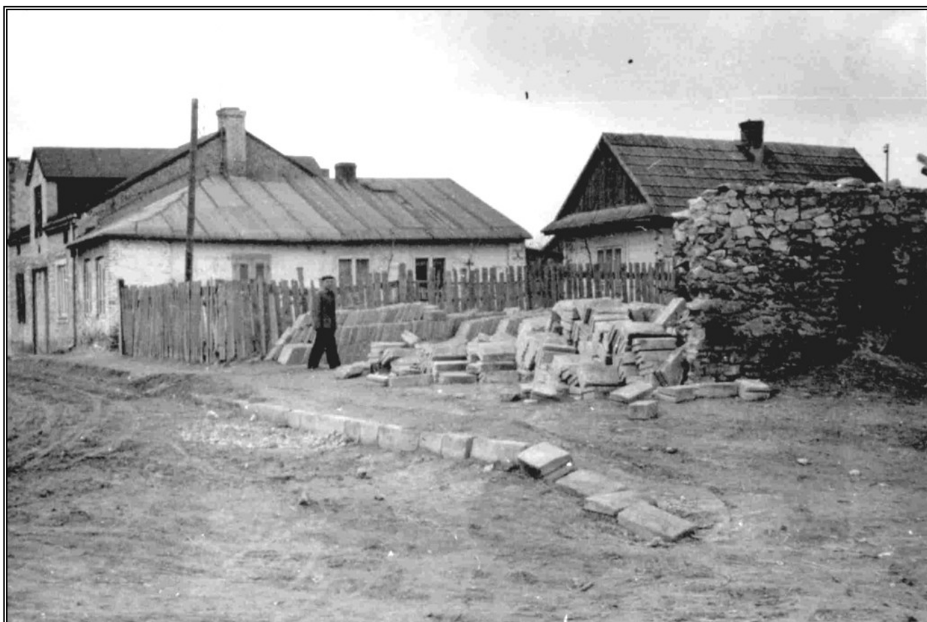
Janów Lubelski, lata 60. ub. w. – przebudowa ul. Lipowej (dziś: Kołłątaja). Fot. Leszek Kącki.
