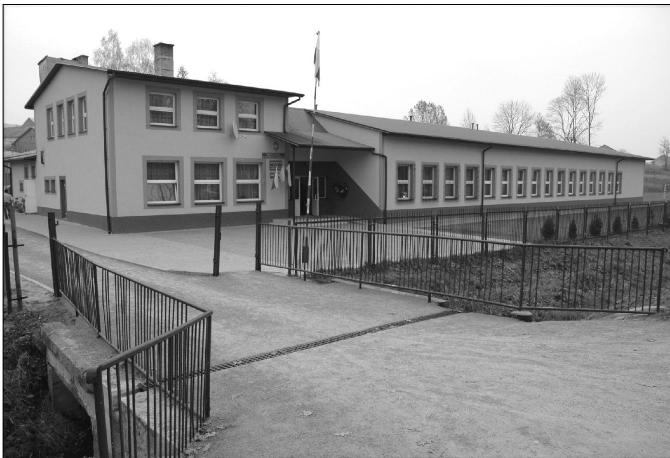
Budynek Zespołu Szkół W Godziszowie Pierwszym – 2005 r.
