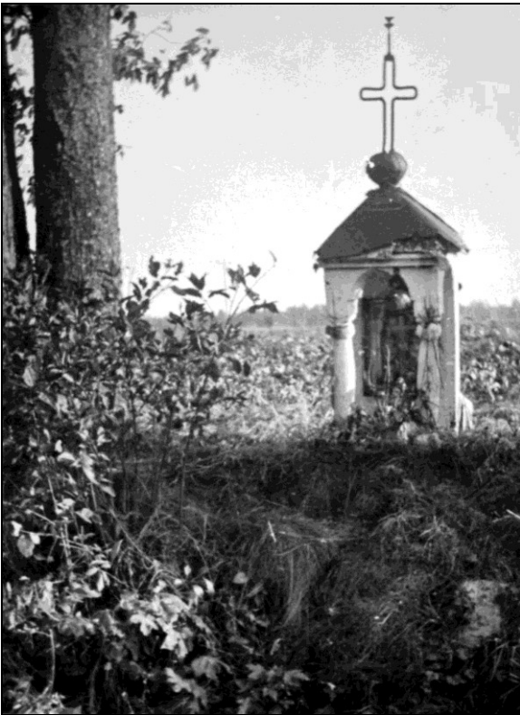
Kapliczka kładowa z Brzezin, 1845 r. (niesistniejąca)
